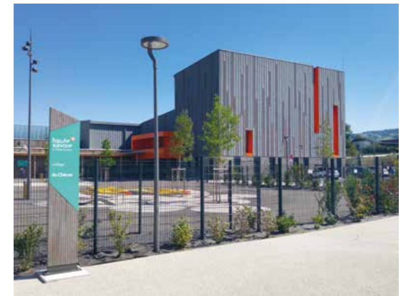
Le gymnase intercommunal du collège du Chéran
